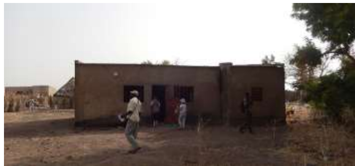
Logement de l'infirmier
