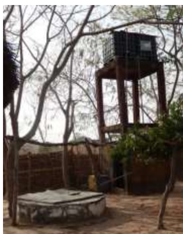
Puits équipé d'une pompe solaire et d'un château d'eau
