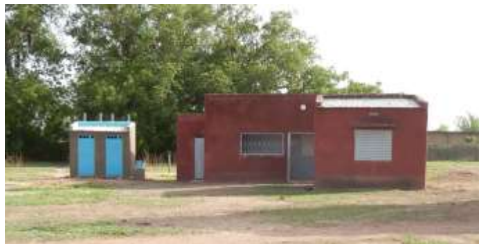
Poste de Santé – vue générale
